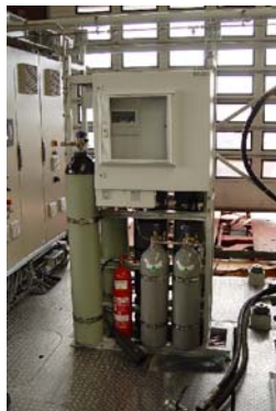
Abbildung 4: Sicherheitsschaltgerät (links) und Brandlöschanlage (rechts)
