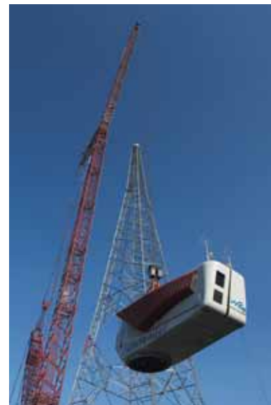
Ganz nach oben: Per Kran wurde die Gondel der FL 2500 in 160 m Höhe gezogen
